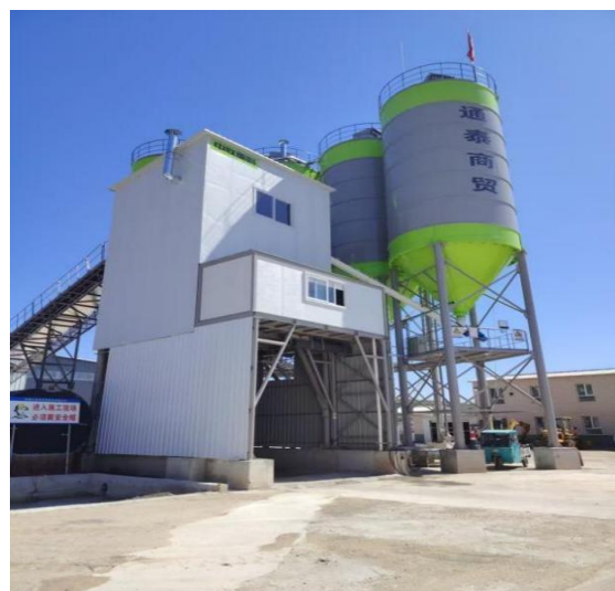
图 3-3 全封闭搅拌塔楼
